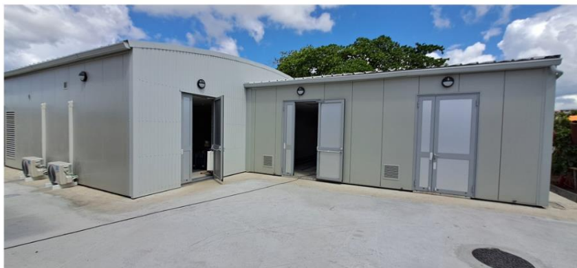
Le nouveau poste source de Dillon
